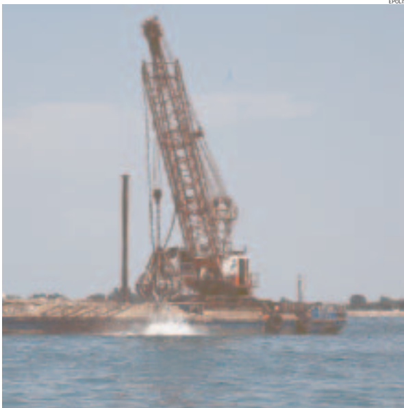
► Uno dei cantieri in attività
