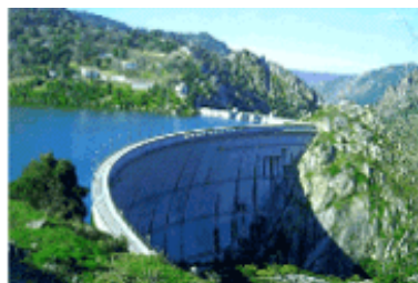
Bacino idrico per la produzione di energia idroelettrica.
