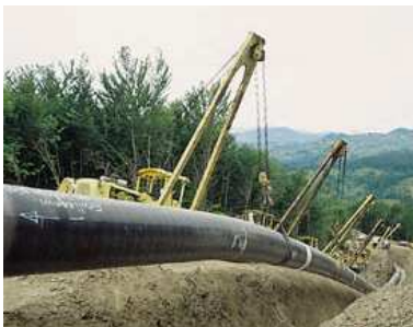
Posa di un gasdotto.
