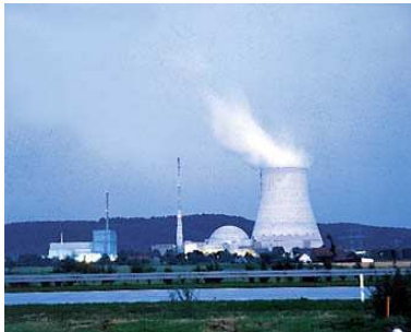
Centrale per la produzione di energia termoelettrica.
